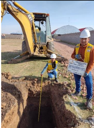
Fotografía 1. Excavación Calicata C-1
