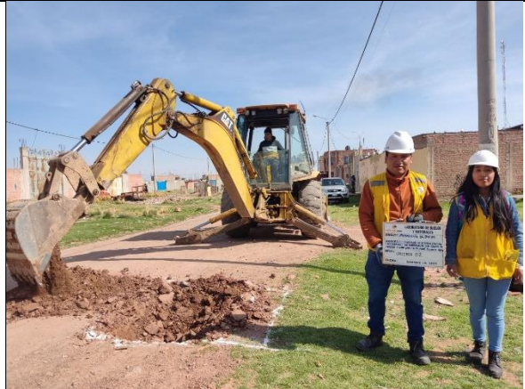
Fotografía 2. Excavación Calicata C-2
