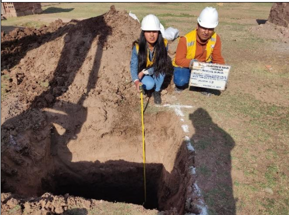
Fotografía 3. Excavación Calicata C-3
