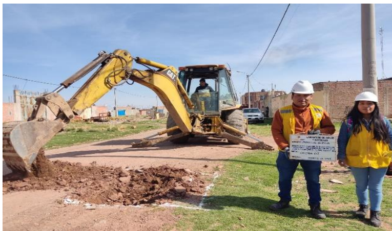
Figura 15. Calicata ejecutada en la Av. Perú
