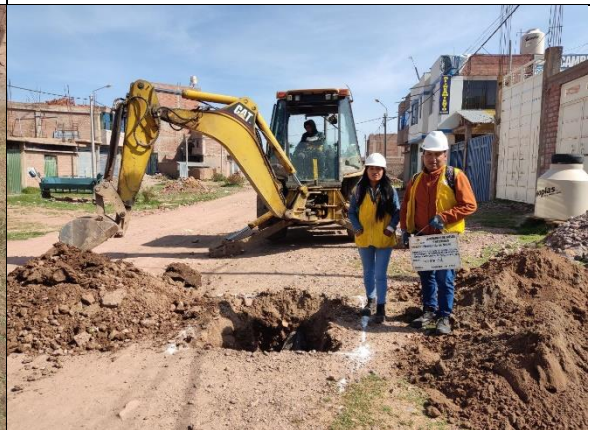
Fotografía 4. Excavación Calicata C-4
