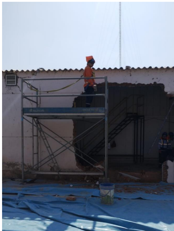
Figura 20. Uso de epps específicos para trabajos en altura
