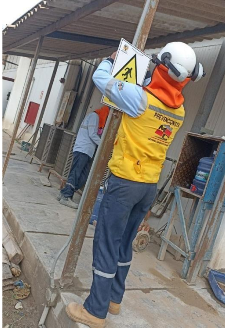
Figura 26. Colocación de señalizaciones en áreas de trabajo
