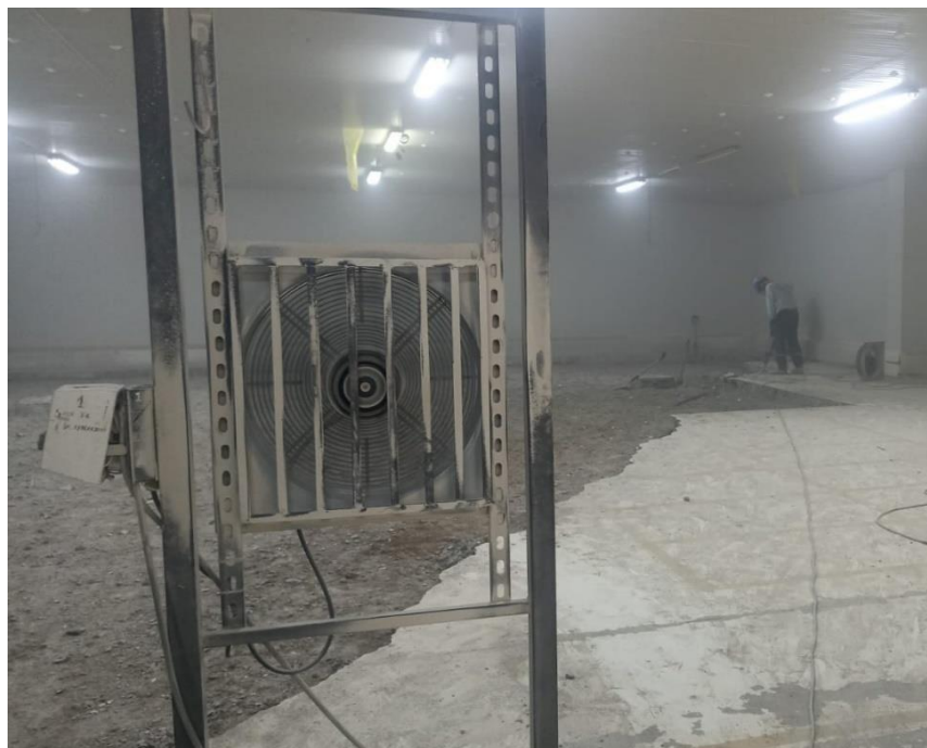
Figura 12. Registro fotográfico de la implementación de extractor de emisiones
