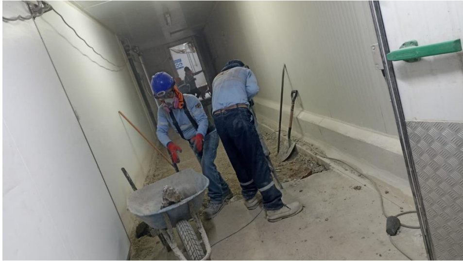
Figura 14. Registro fotográfico el uso de epps para el riesgo de inhalación, intoxicación por polvo o partículas
