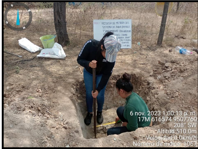
DESCRIPCIÓN: Prueba de test de percolación.
