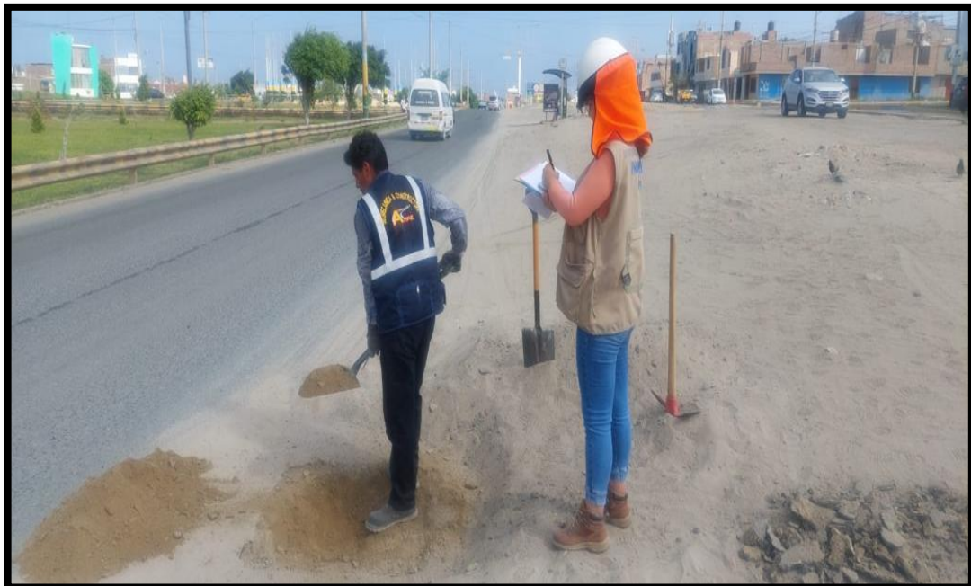
Foto N°2. Extracción de calicatas in situ
