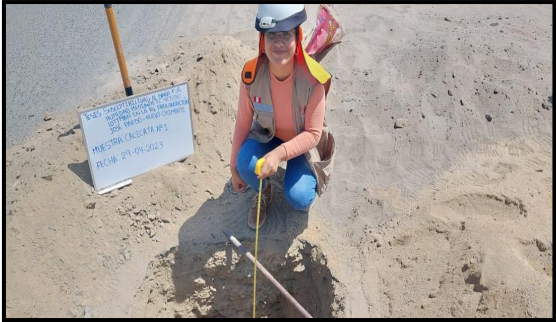
Foto N°3. Medición de la calicata N°1
