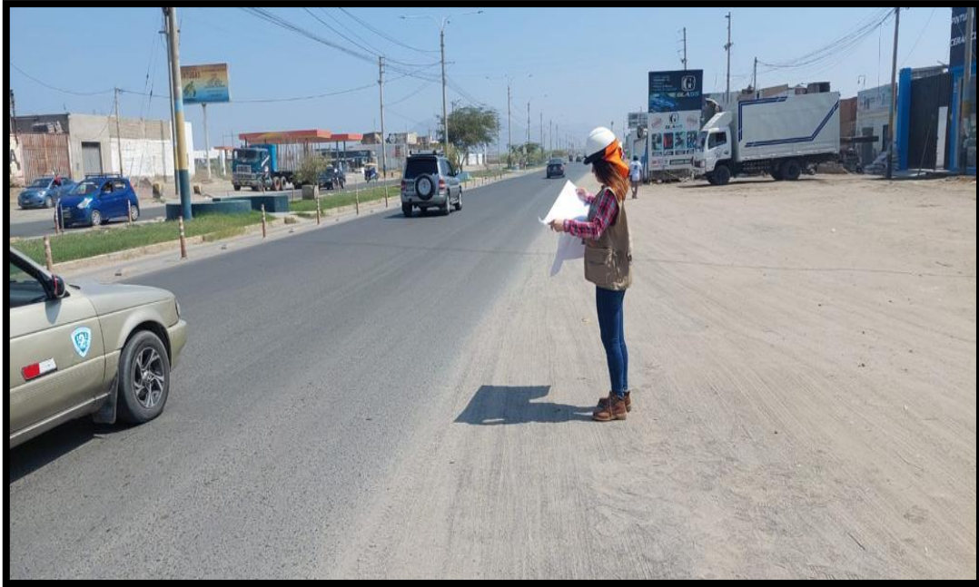
Foto N°1. Revisión de plano para proceder a la excavación de las calicatas
