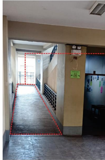
Rampas para el fácil acceso con medidas adecuadas.
