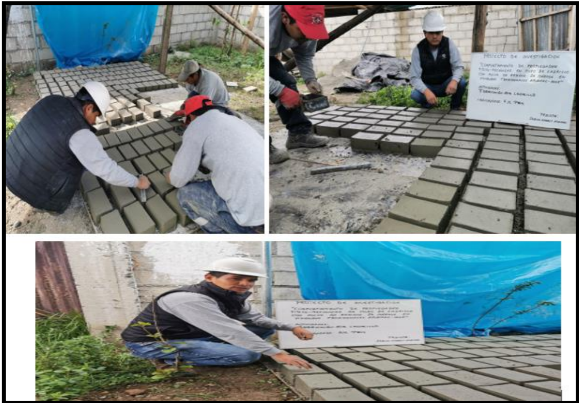
Fabricación de ladrillos con adición del polvillo de residuo de mármol según los indicadores de 4%PRM, 5%PRM y 6%PRM.
