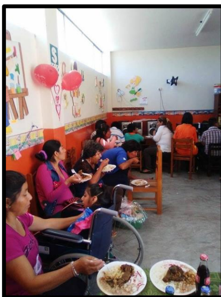
Figura 2. Condiciones de espacios didácticos interiores inadecuadas del CEBE del centro poblado de Cormot – distrito de Marmot.
