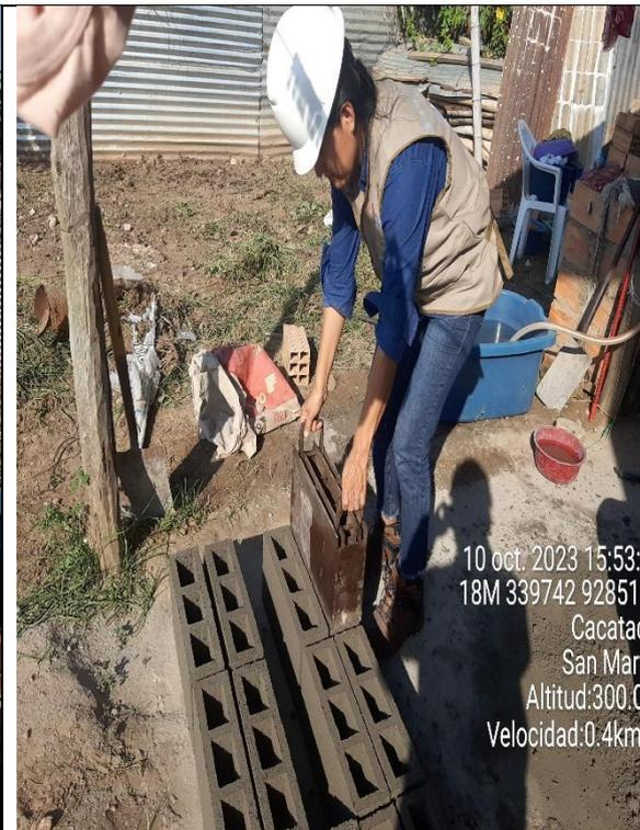
Desmontado de los bloques de concreto
