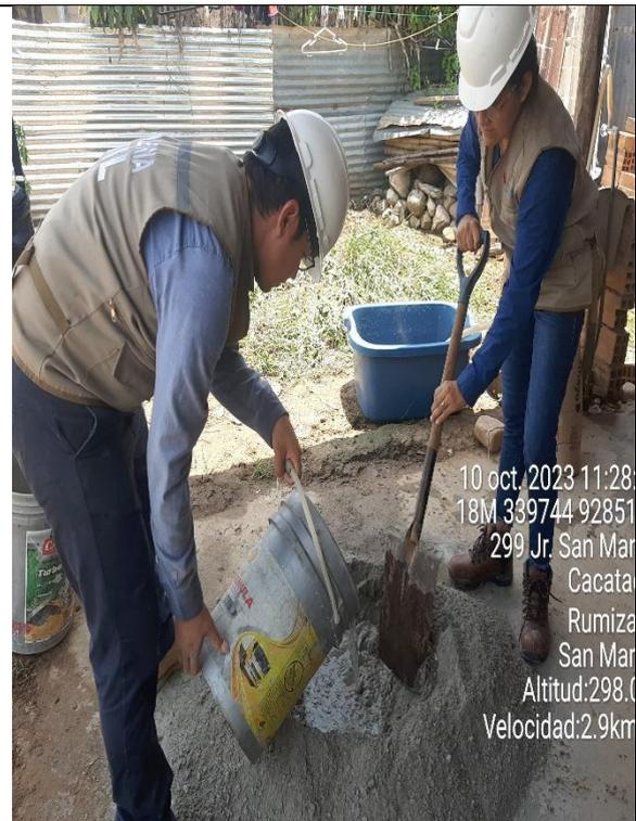
Vaciado del agua para la mezcla
