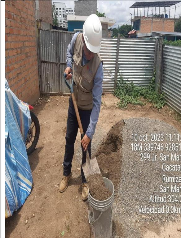
Dosificando el material agregado
