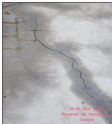
Figura 02. Fisuras en concreto.
