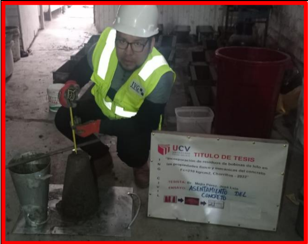
Asentamiento y consistencia del concreto
