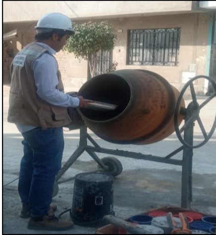
Fig. N°26 - Elaboración de mezcla.
