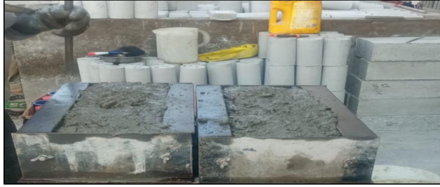
Elaboración de vigas.
