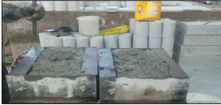
Fig. N°31 – Elaboración de vigas.
