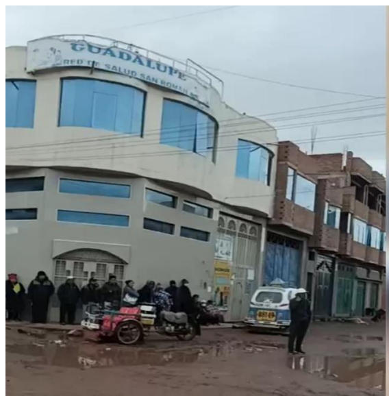
En esta etapa, se acondicionó la vivienda para mejorar los espacios internos para consultorios y otros.
