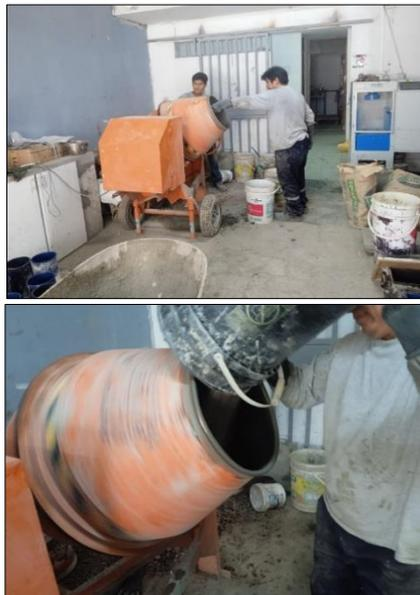
Fotografía 19. Preparación del concreto
