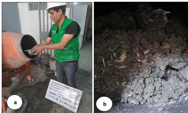
**Figura 13:** (a) y (b) incorporación de las CGD Y FGD en la mezcla
