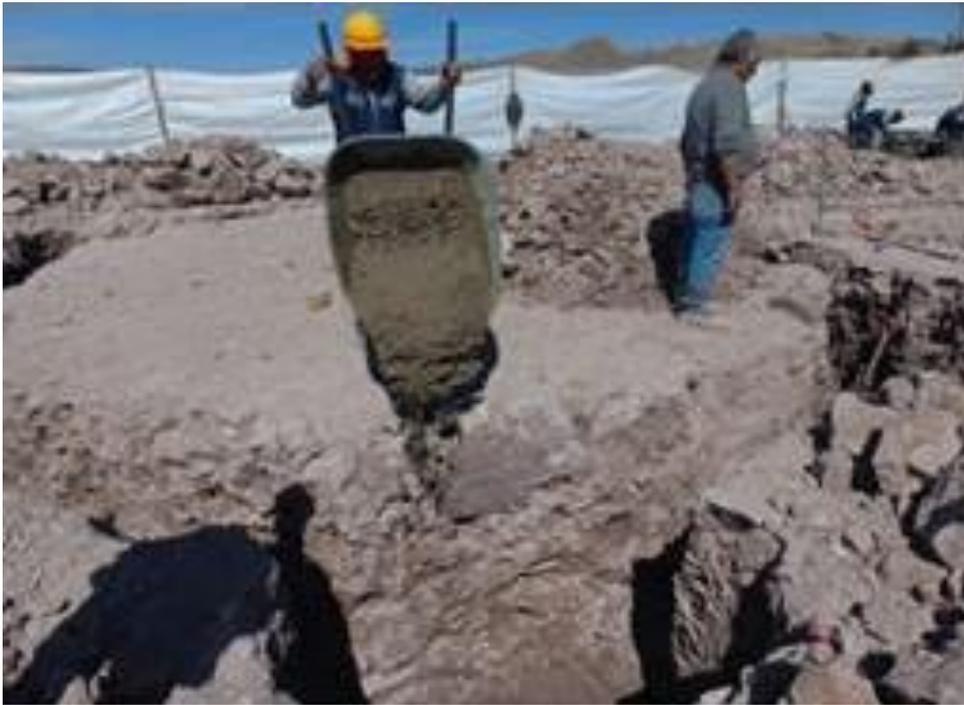
Figura 14. Vaciado de concreto en etapa de estructura.
