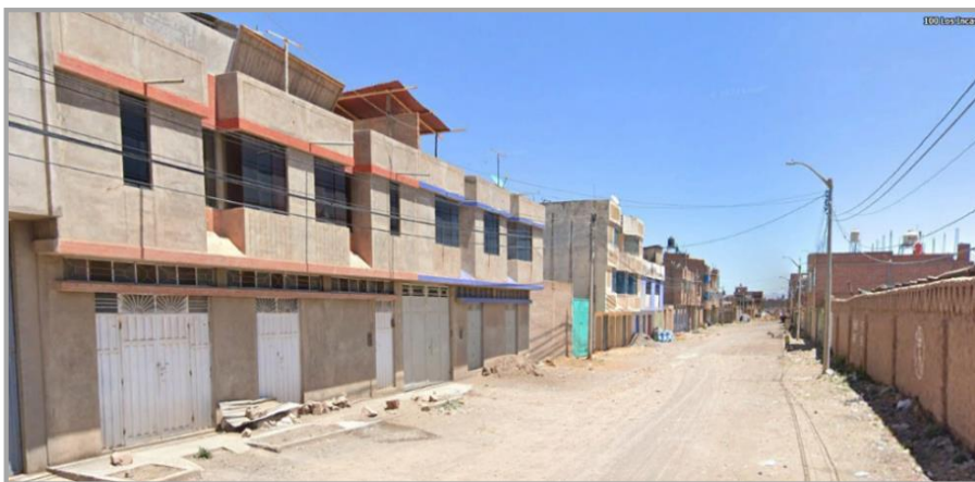
Figura 40. Jr. los incas, viviendas con revestimiento de concreto.
