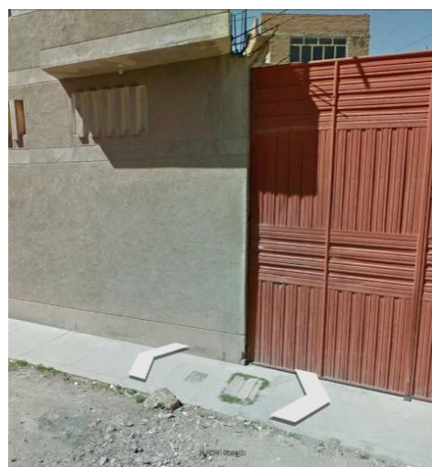
Figura 49. Instalación de desagüe.
