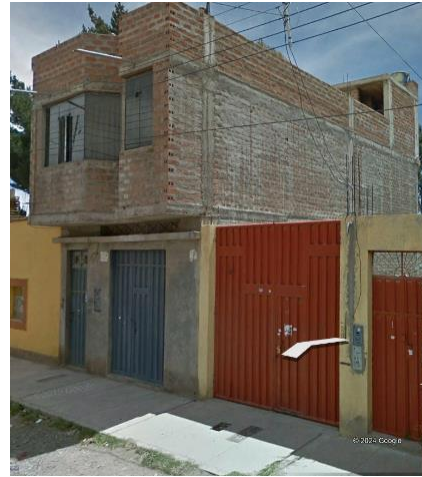
Figura 51. Instalación eléctrica domiciliaria.
