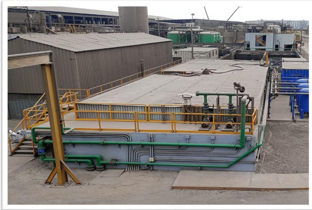
Reservorio R8E agua permeada y agua de rechazo (este reservorio tiene dos compartimientos)
