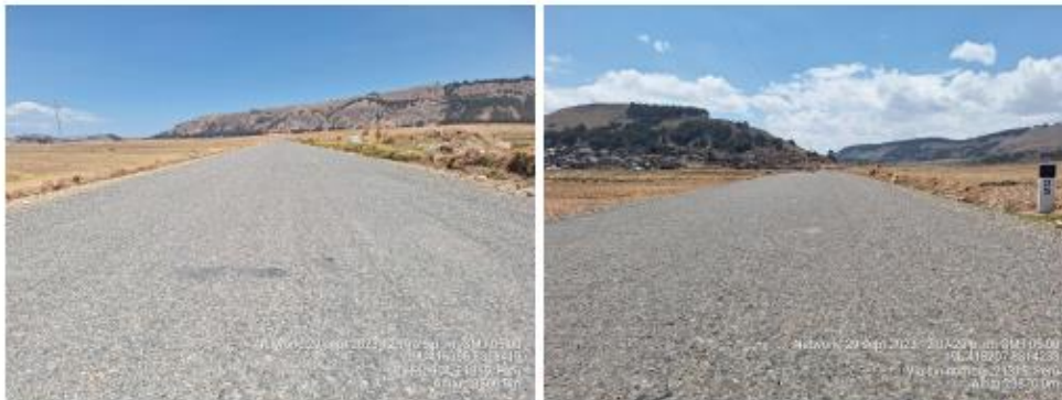
Fig N° 9: Estado de la Vía en Otta Seal
