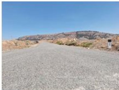
ESTADO DE LA VIA A NIVEL DE OTTA SEAL
