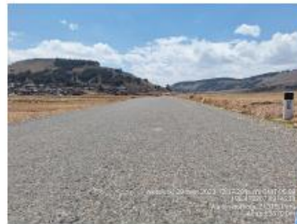
ESTADO DE LA VIA A NIVEL DE OTTA SEAL
