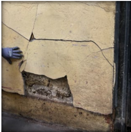
Figuras 55 y 56: Erosión de muros por humedad. Fuente: Propia.
