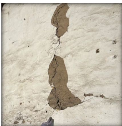
Figuras 60 y 61: Grietas y colapso de muros. Fuente: Propia.
