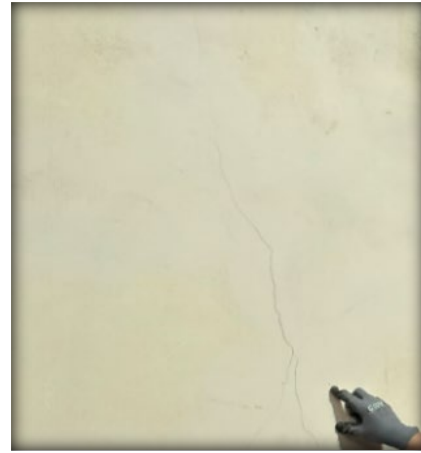
Figuras 30 y 31: Fisuras y grietas verticales en muros. Fuente: Propia.
