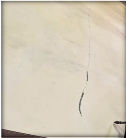
Figuras 30 y 31: Fisuras y grietas verticales en muros. Fuente: Propia.
