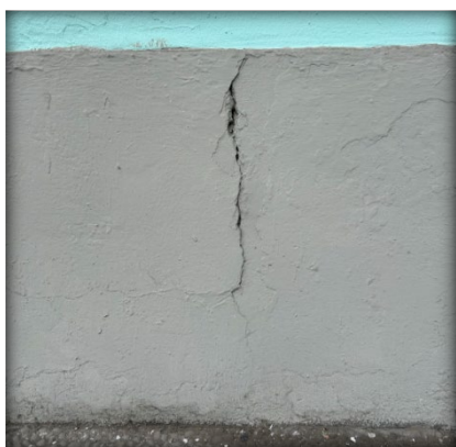
Figuras 26 y 27: Grietas en muros y sardineles. Fuente: Propia.
