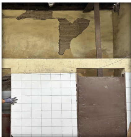
Figuras 53 y 54: Grietas en muros y colapso de techo. Fuente: Propia.
