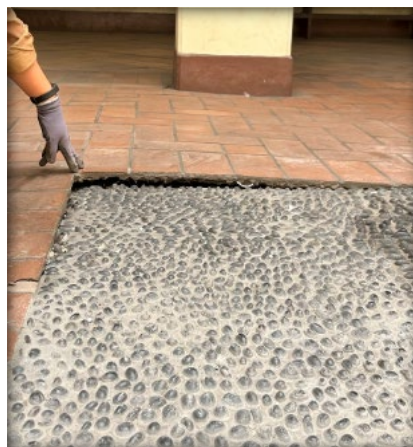
Figuras 33 y 34: Asentamiento del suelo. Fuente: Propia.
