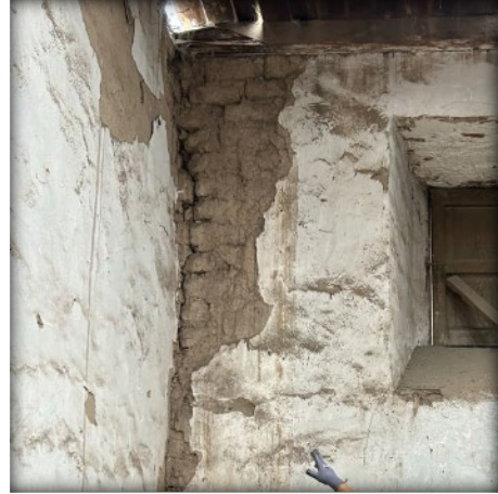
Figuras 43 y 44: Falta de arriostramiento de muros portantes. Fuente: Propia
