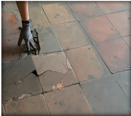
Figuras 37 y 38: Desprendimiento de pisos y grietas en muros.
