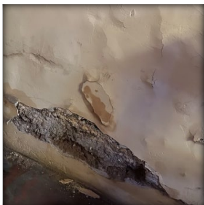
Figuras 58 y 59: Degradación de muros. Fuente: Propia.
