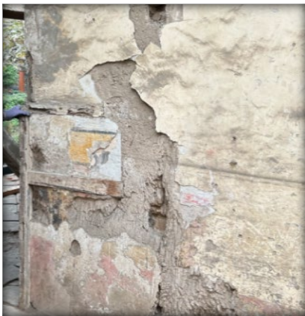
Figuras 45 y 46: Grietas verticales y pérdida de muros. Fuente: Propia.
