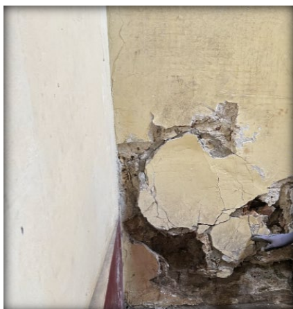
Figuras 51 y 52: Erosión de muros por humedad. Fuente: Propia.
