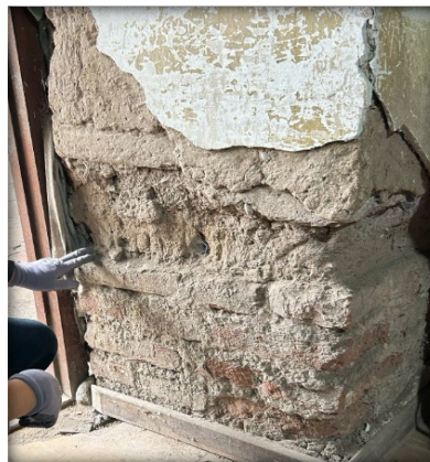
Figuras 40 y 41: Pérdida parcial de base de muros. Fuente: Propia
