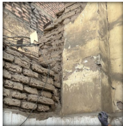
Figuras 49 y 50: Asentamiento del suelo y colapso de muros. Fuente: Propia.
