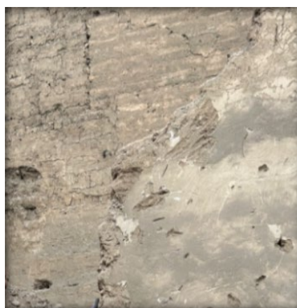
Figuras 60 y 61: Grietas y colapso de muros. Fuente: Propia.
