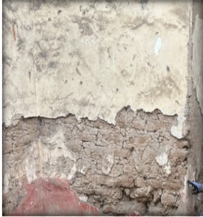
Figuras 47 y 48: Pérdida parcial de muros. Fuente: Propia.
