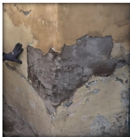
Figuras 51 y 52: Erosión de muros por humedad. Fuente: Propia.
