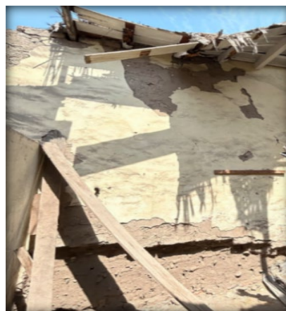
Figuras 53 y 54: Grietas en muros y colapso de techo. Fuente: Propia.
