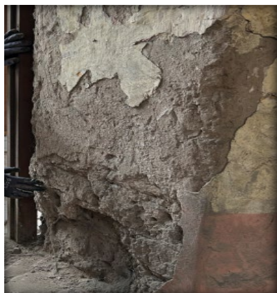
Figuras 40 y 41: Pérdida parcial de base de muros. Fuente: Propia
