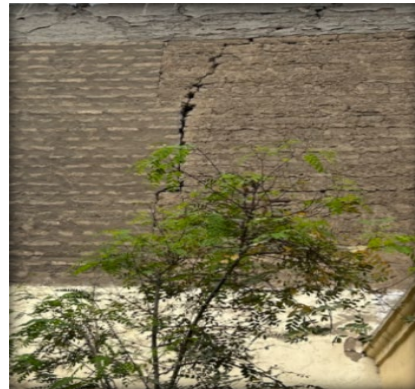
Figuras 37 y 38: Desprendimiento de pisos y grietas en muros.
