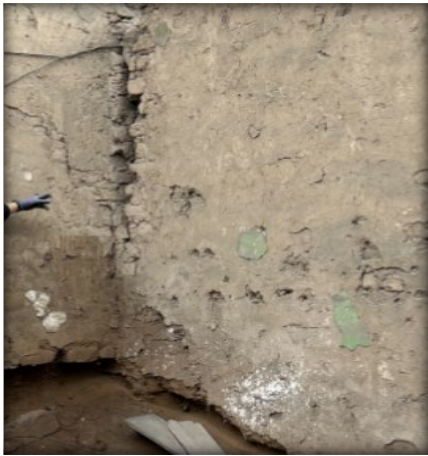
Figuras 43 y 44: Falta de arriostramiento de muros portantes. Fuente: Propia
