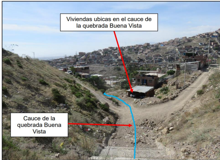
Figura 15. Pase vehicular en cauce.
