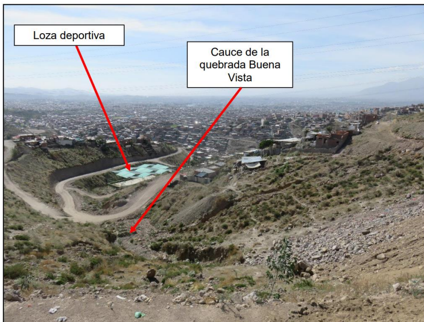
Figura 16. Cauce Quebrada Buena Vista.
