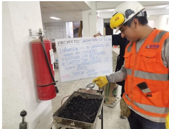
Figura 13. Calentamiento del asfalto
