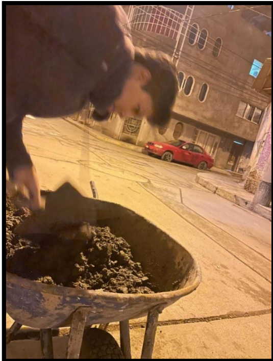
Foto 41: Preparación de concreto
