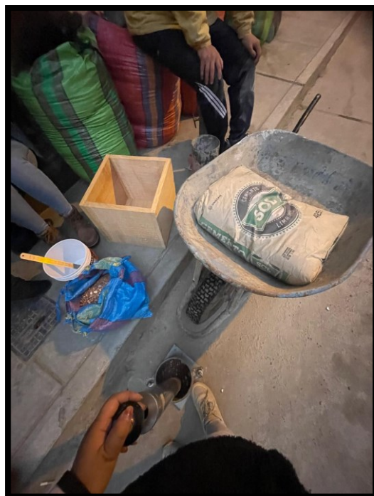
Foto 38: Preparación de concreto
