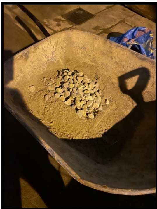
Foto 39: Preparación de concreto
