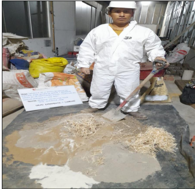
Figura 31. Mezclado de la arcilla
