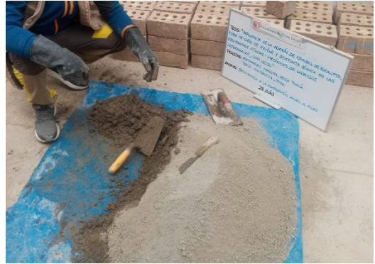
Foto 62. Proceso de mezclado de mortero para asentado
