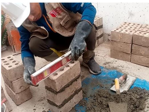
Foto 65. Nivelación de murete con nivel de mano
