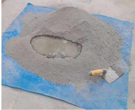
Foto 61. Mezclado de cemento, agua y arena para mortero
