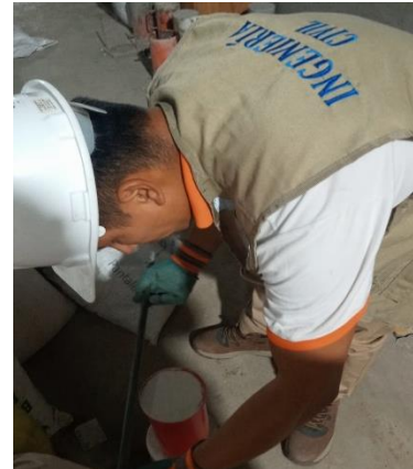
Foto 32. Material compactado de la bentonita sódica
