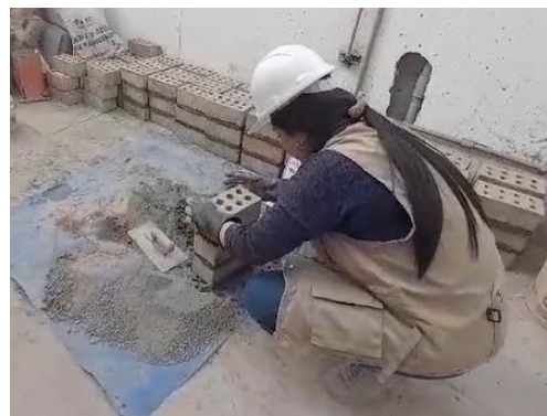
Foto 64. Colocación de asentado de ladrillos con mortero preparado
