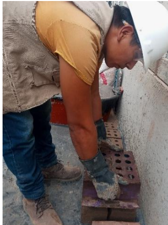
Foto 51. Desmoldado de ladrillo para secado
