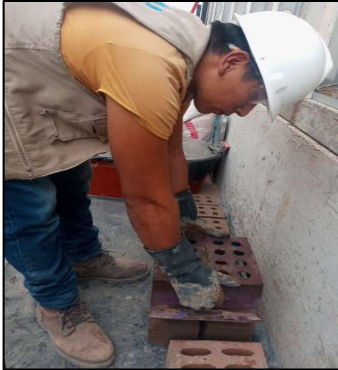
Figura 33. Vaciado y moldeado de los ladrillos artesanales
