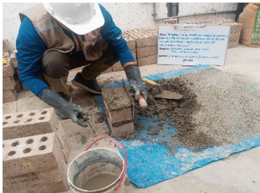
Foto 63. Colocación de asentado de ladrillos con mortero preparado
