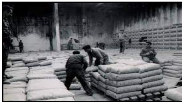
Figura 3. Producción del cemento Pórtland Fuente. http://bitly.ws/Dva2
