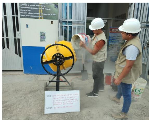
Figura 13. Mezclado de componentes para la producción de concreto
