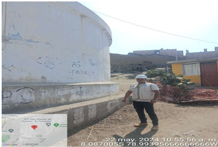
Foto 06: Visita al reservorio El Presidio – El Porvenir, Trujillo.
