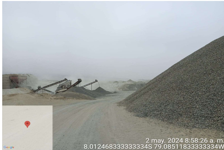
Foto 01: Visita a la cantera Lekersa para la compra de los agregados.
