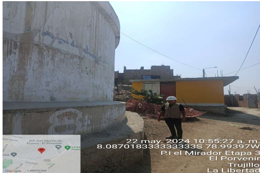
Foto 07: Visita al reservorio El Presidio – El Porvenir, Trujillo.
