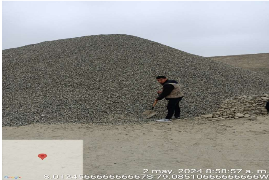
Foto 05: Tesista adquiriendo agregado grueso.
