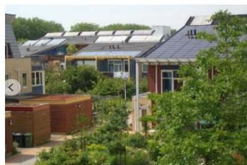
Las viviendas contemplan en su cubierta Paneles solares que brindan energía limpia, así mismo estos techos son cubiertos por laminas EPDM que
