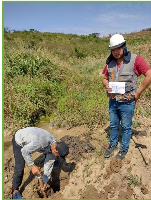
EXCAVACION DE CALIATAS
