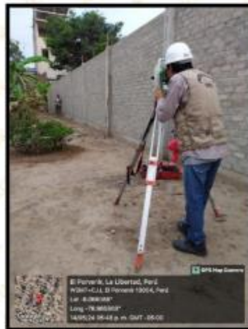
Imagen 1: Ubicación de la estación total para el levantamiento topográfico.
