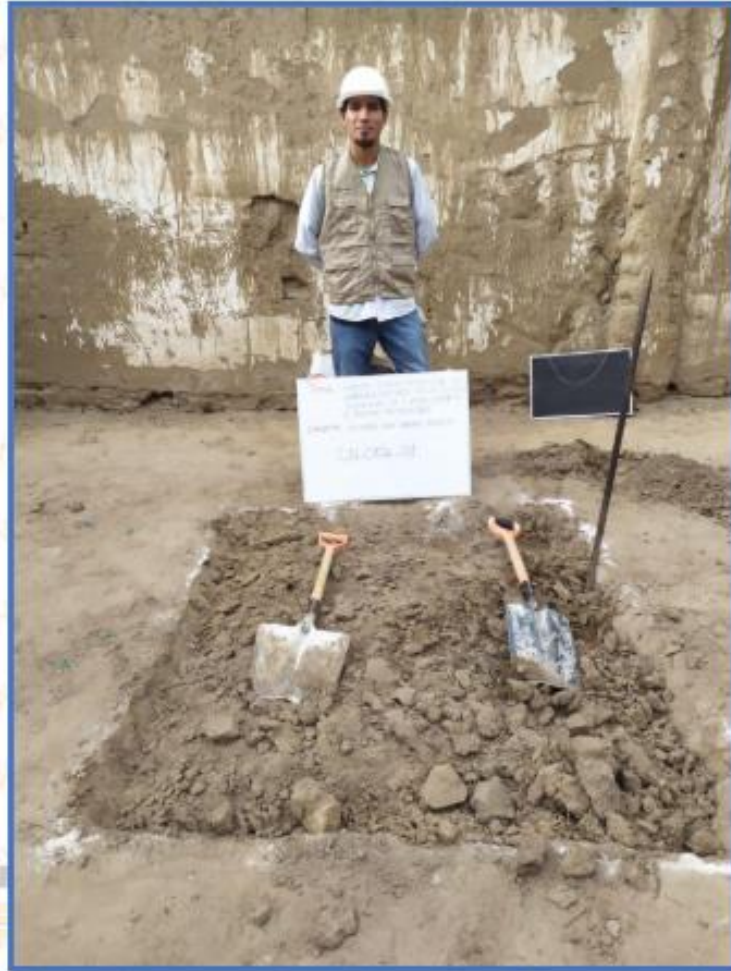
Imagen 3: Área antes de que se realice la excavación
