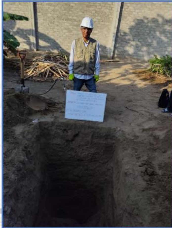
Imagen 1: Calicata 1 con una profundidad de 3.00 m (721966.86m E; 9107838.69m N)
