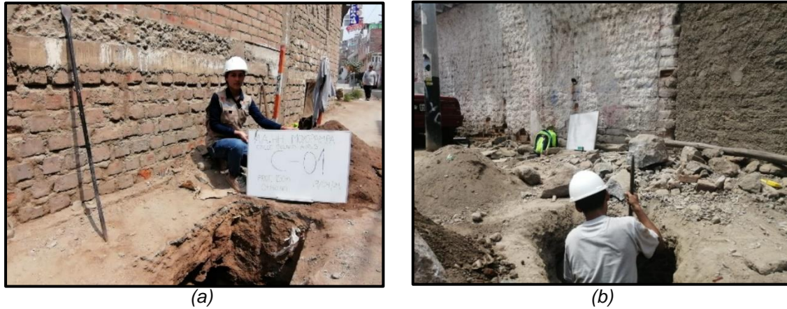
Figura 9. Calicatas a 0+140 km y 0+390 km
