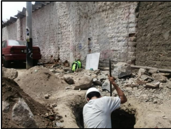
Panel fotográfico N° 5: Inicio de la excavación de la calicata N°2 de la calle Buenos Aires.
