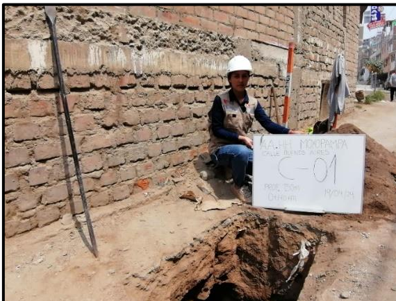
Panel fotográfico N° 3: Calicata N°1 de la calle Buenos Aires del AA.HH Moyopampa.
