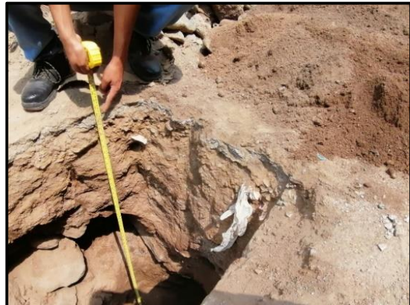
Panel fotográfico N° 2: Excavación hasta 150cm de profundidad.
