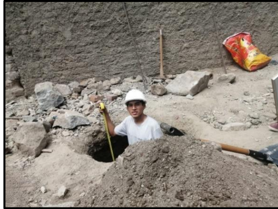
Panel fotográfico N°6: Excavación de una profundidad de 150cm de altura del Jirón La
