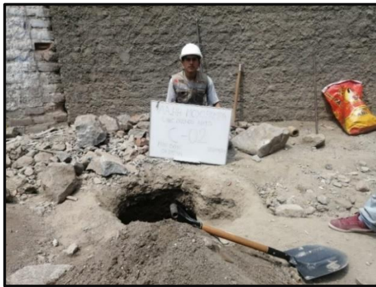
Panel fotográfico N°6: Calicata N°2 de la calle Buenos Aires del AA.HH de Moyopampa.
