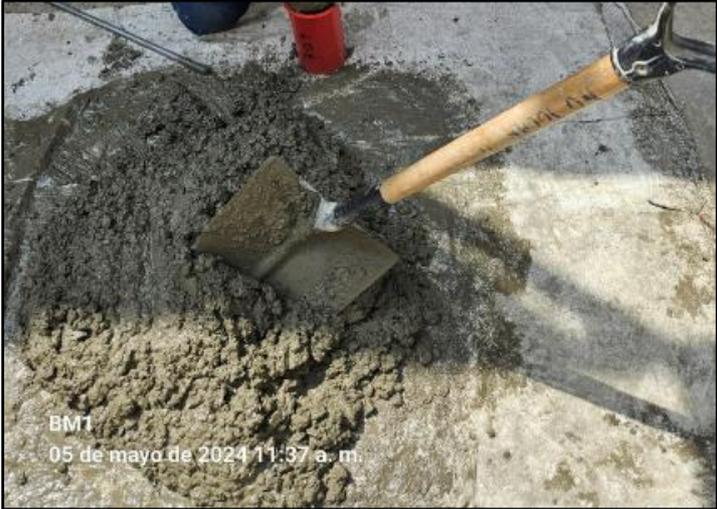
Figura 20. Mezcla de concreto de diseño patrón
