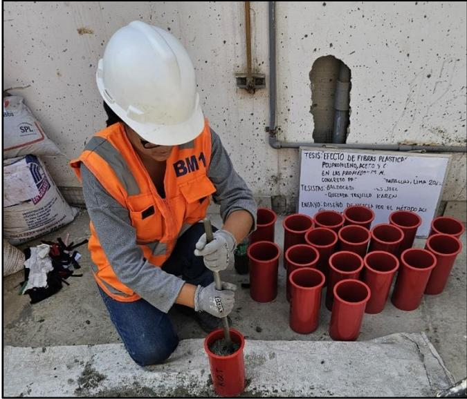
Figura 24. Varillado de probetas concreto patrón
