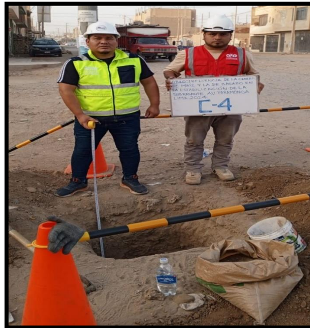
Figura 12. Excavación de calicata – 4.
