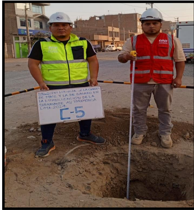
Figura 13. Excavación de calicata 5.
