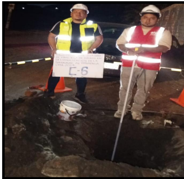
Figura 14. Excavación de calicata 6.
