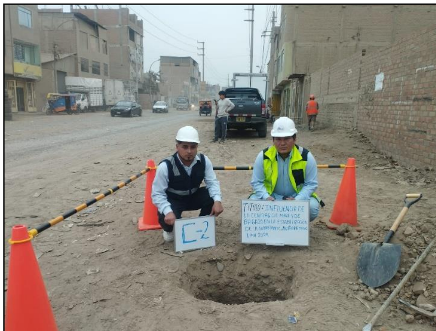
Figura 10. Excavación calicata - 2.
