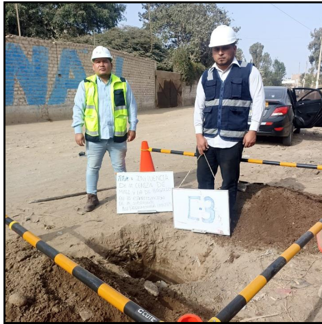
Figura 11. Excavación calicata - 3.
