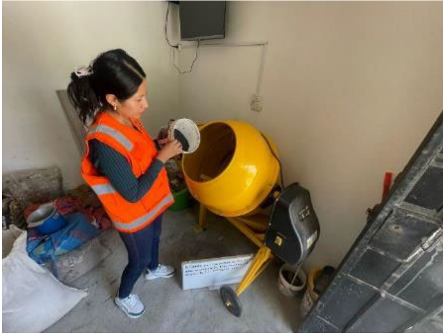
Figura 10. Preparación del concreto con incorporación de escoria
