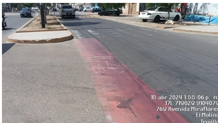
Figura 3. Ciclovía Desaparecida Av. Miraflores – Invasión de Carril
