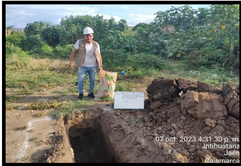
Foto 3: Extracción de muestra de calicata C-02.
