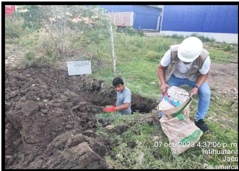
Foto 4: Extracción de muestra de calicata C-03.
