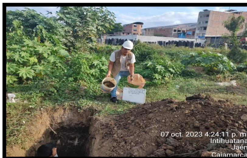
Foto 2: Extracción de muestra de calicata C-01.
