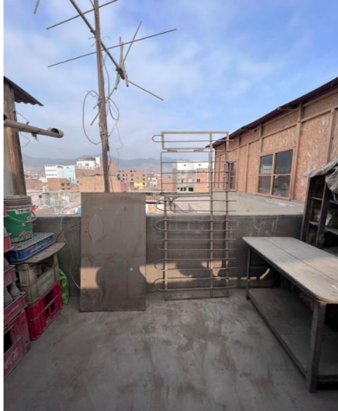
Figura 02: Terreno listo donde será instalado el sistema hidropónico NFT
