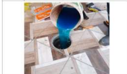
DESCRIPCIÓN VACIADO DE LA PREPARACION DE LOS ADITIVOS SALES HIGROSCOPICAS THORGEI.
