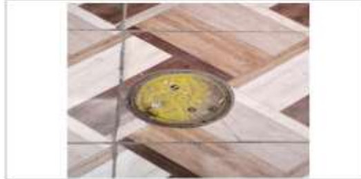
DESCRIPCIÓN ESTADO INICIAL DEL POZO A TIERRA
