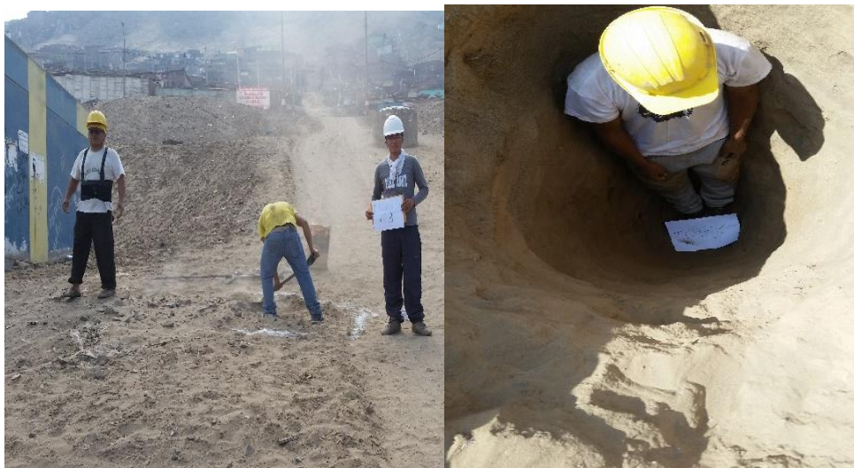
Replanteo de la calicata N° 03
