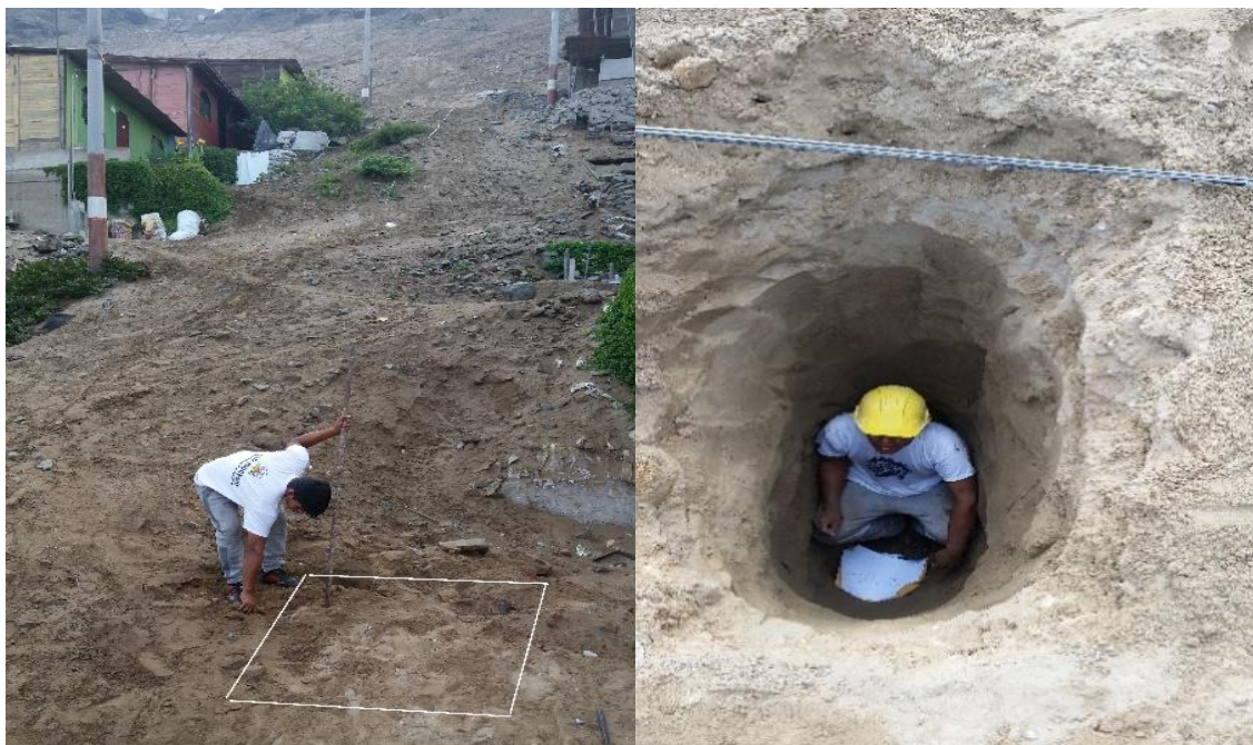
Replanteo de la calicata N° 01
