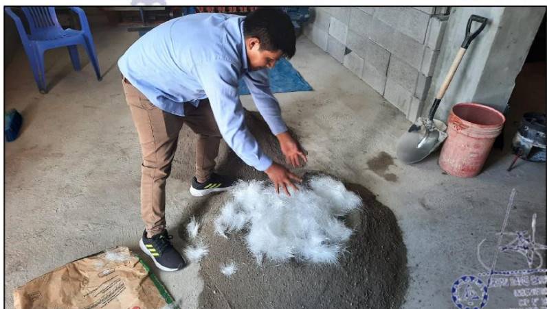
Ilustración 32 INCORPORANDO 0.5% DE FIBRA DE VIDRIO AL 0.5 %
