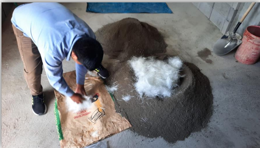
Ilustración 33. Preparación del concreto con la incorporación de la fibra de vidrio.
