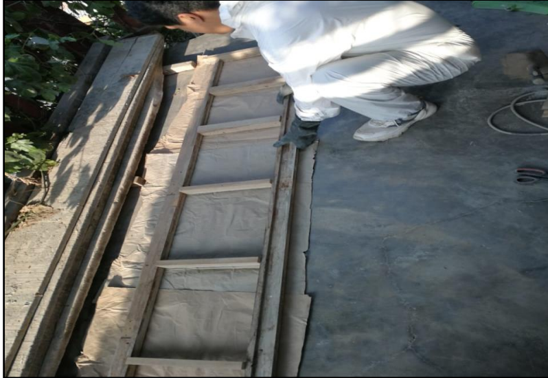
Figura 24. Armado de molde de placas de maqueta
