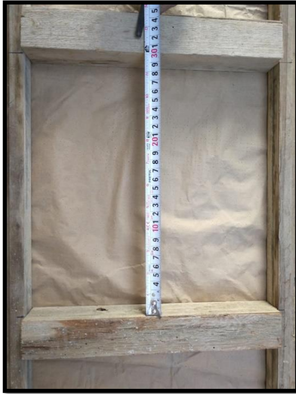
Foto 15. Armado para el enconfrado de prototipos
