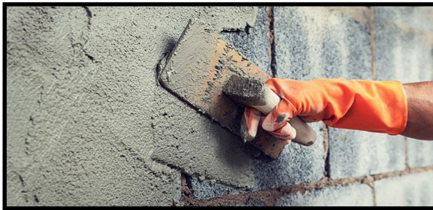
Figura 5. Revestimiento de muros
