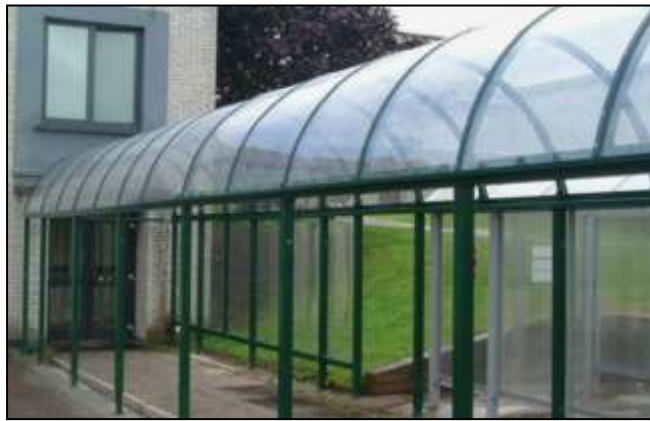
Figura 8. Techo de Policarbonato
