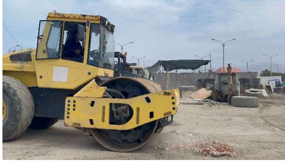
Foto N°09: Tritutado de RCD recolectado
