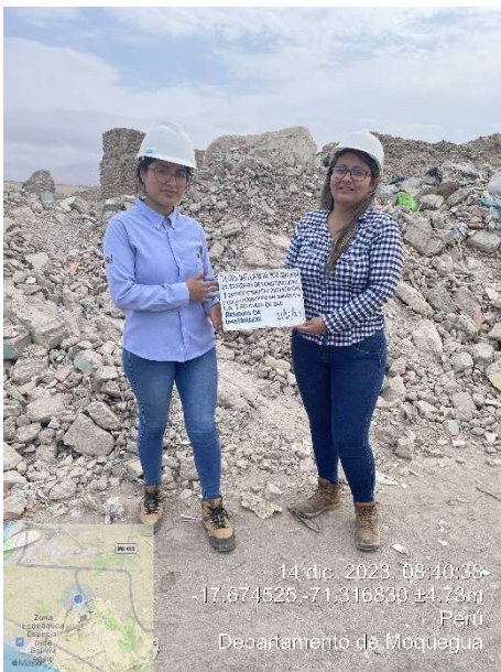
Foto N°07: Recolección de RCD de botadero municipal
