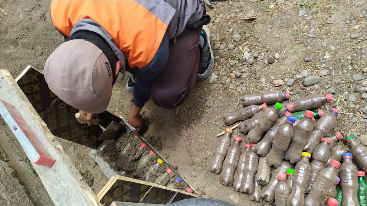
*Figura 413. Asentado de murete con botellas rellenas de suelo común*
