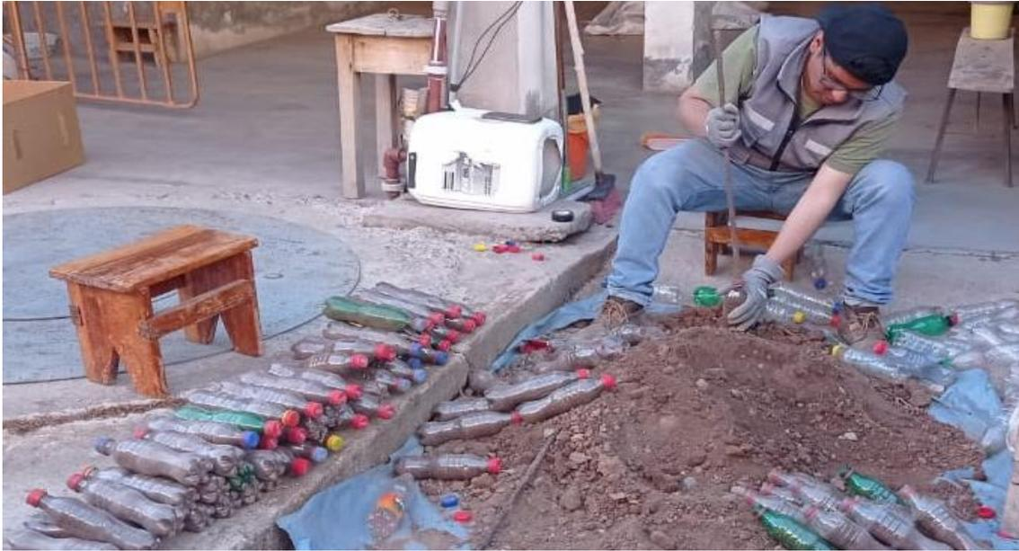
Figura 345. Llenado de botellas PET con suelo común y compactado por capas
