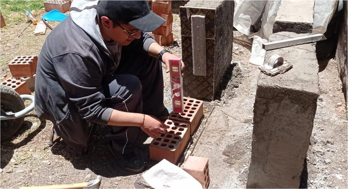
Figura 435. Asentado de murete ladrillo Tipo I.
