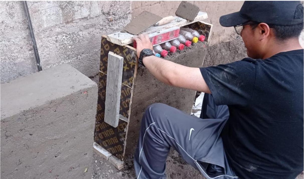
*Figura 424. Asentado de murete con botellas rellenas de suelo común*
