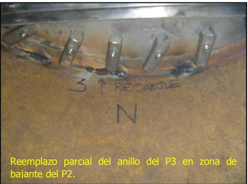
Reemplazo parcial del anillo del P3 en zona de bajante del P2.
