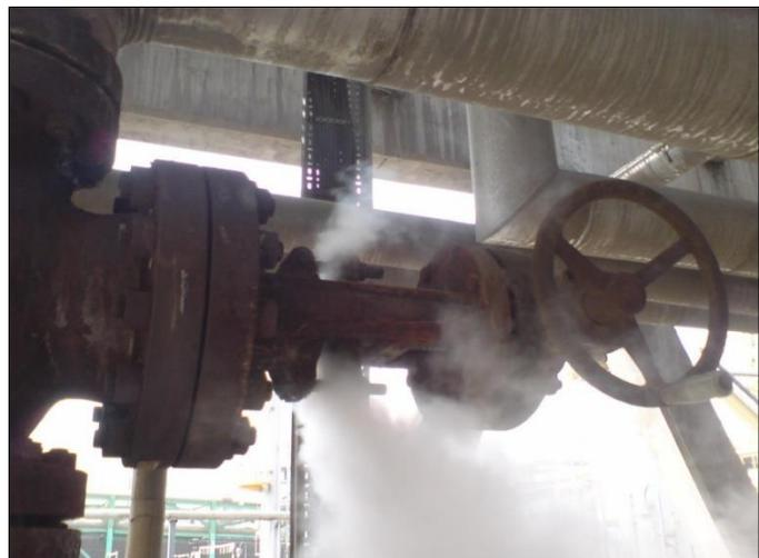
Teniendo en cuenta que no ha sido posible efectuar el reempacado de la prensaestopa, se recomienda como reparación temporal, instalar capucha de acuerdo al gráfico adjunto, desde la brida del cuerpo hasta cubrir la caja reductora (retirar la volante). El material a utilizarse debe ser un tubo fabricado a partir de plancha de A/C A36 de 3/4"thk y tapas de 1-1/4" de espesor; usar electrodo E7018. Alternativamente, considerar la reparación mediante la inyección de sellante (retacado).
