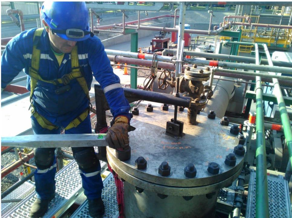
Ajuste de tapa bridada con equipo de torque controlado.
