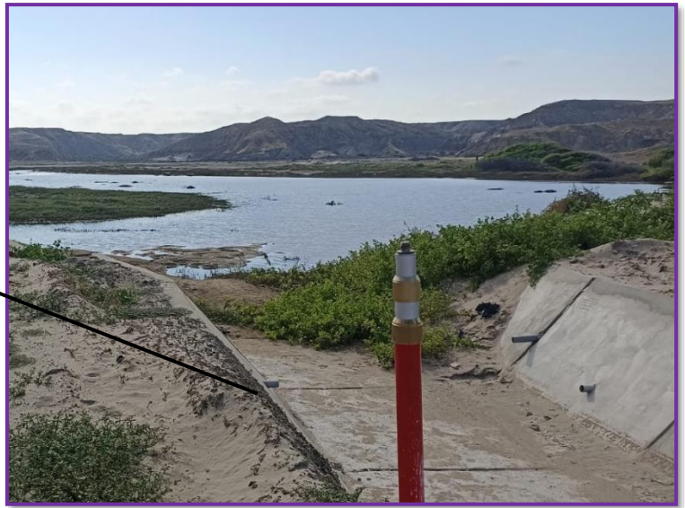
Imagen 19 estado actual de canal de concreto
