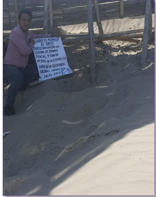
Imagen 09: excavación de calicatas
