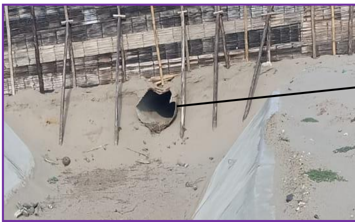
Imagen 20 estado actual de alcantarilla metálica
