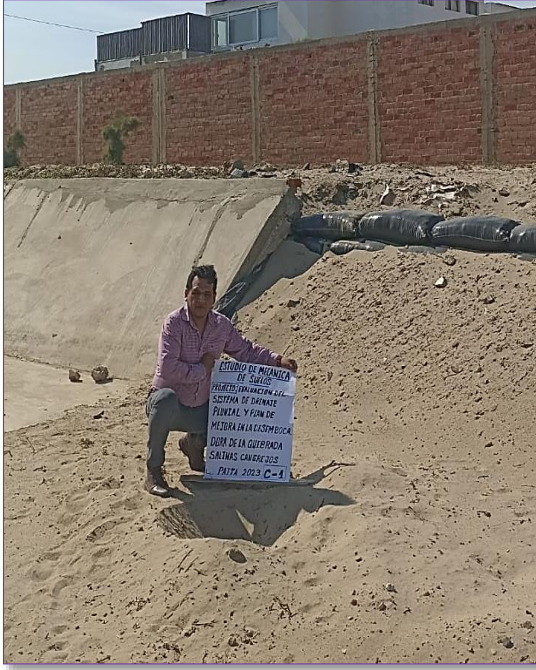
Imagen 08: Excavación de calicatas
