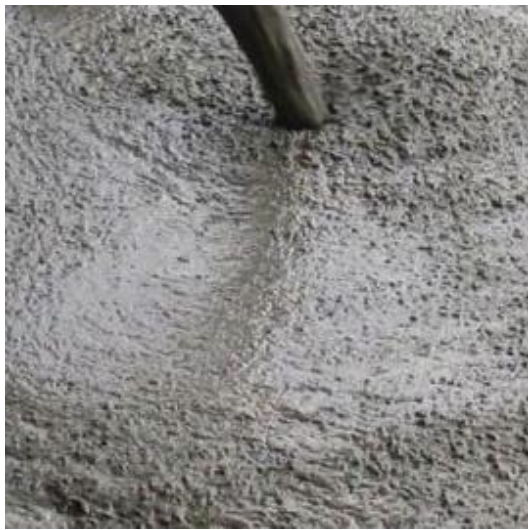
Figura 2. Preparación de concreto
