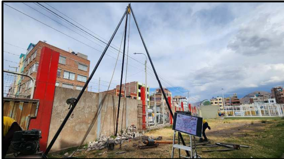
Fotografía N° 07: Ejecución de ensayo SPT-2.
