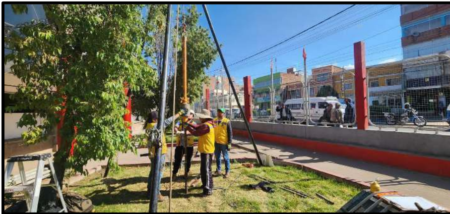
Fotografía N° 10: Ejecucion del ensayo SPT-3.
