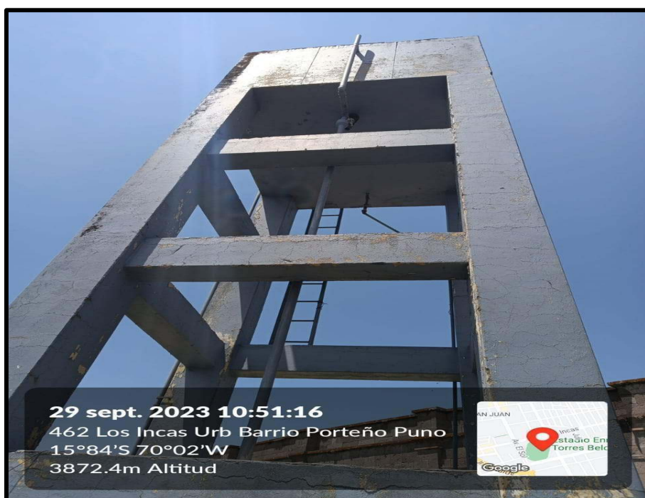
Fotografía N° 02: Vista frontal del tanque elevado.
