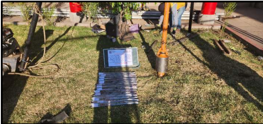
Fotografía N° 11: Muestra del ensayo SPT-3.
