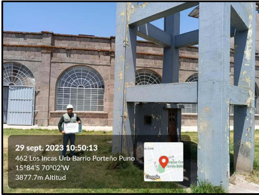
Fotografía N° 03: Vista del tanque elevado en la ubicación de interés.
