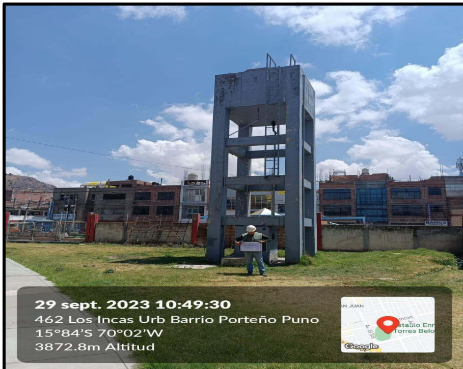
Fotografía N° 04: Vista comparativa de altura del tanque elevado.
