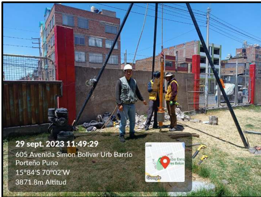
Fotografía N° 05: Ejecución del ensayo SPT-1
