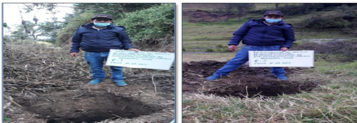
Figura 17. Excavación y extracción de muestras de las calicatas C1 y C2.
