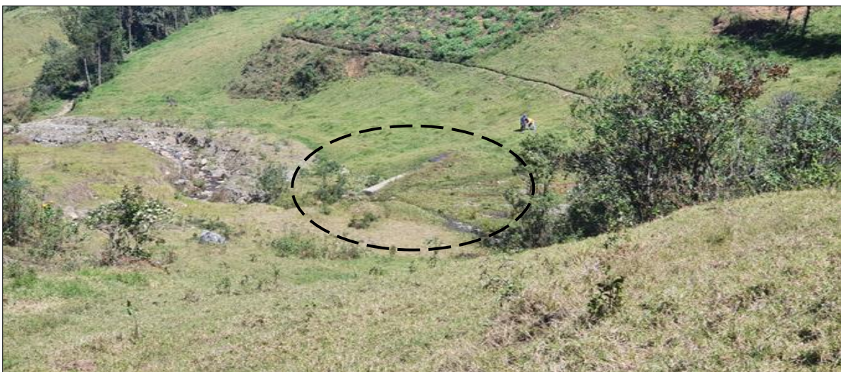
Figura 16. Vista del reservorio totalmente colmatado.
