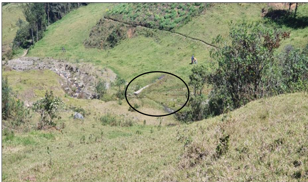
Foto N° 02: Se visualiza el reservorio totalmente colmatado.
