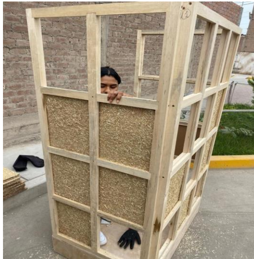
Figura N° 9 Colocación de placas
