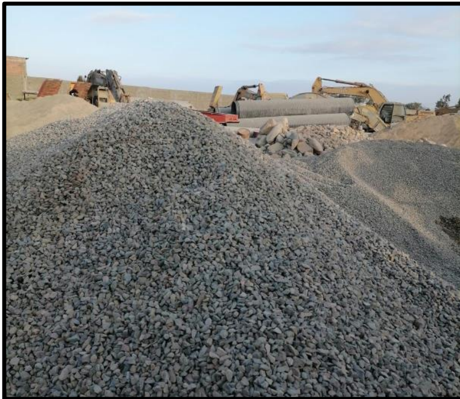
FOTOGRAFIA 2. RECOLECCIÓN DE AGREGADO GRUESO (PIEDRA)
