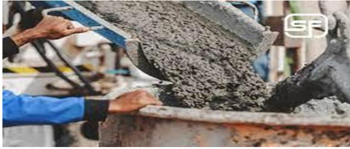
Figura 11. Concreto utilizado en edificaciones civiles
