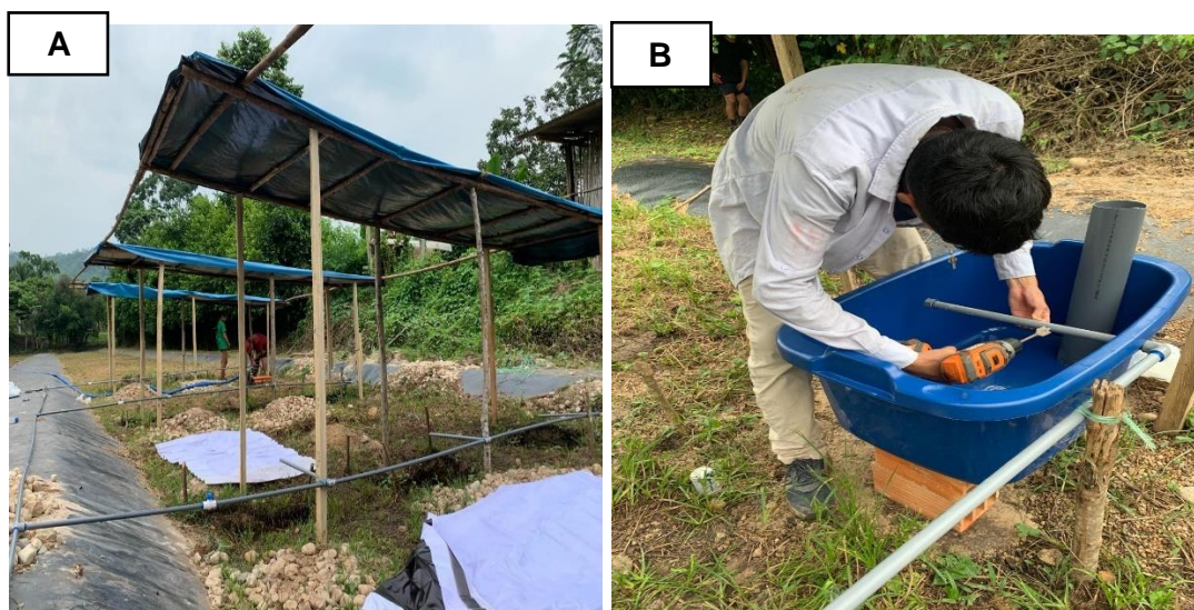
Figura 4. Instalación del abastecimiento de las aguas
